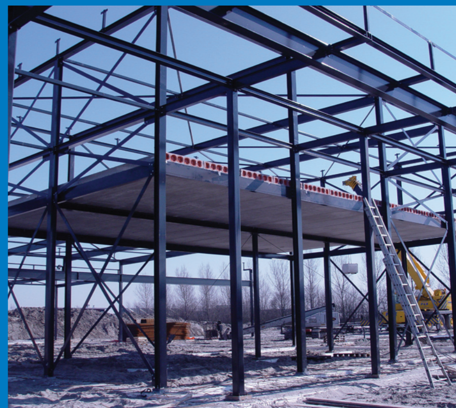
de cleanroomruimte van tbp voor hoogwaardige assemblage
