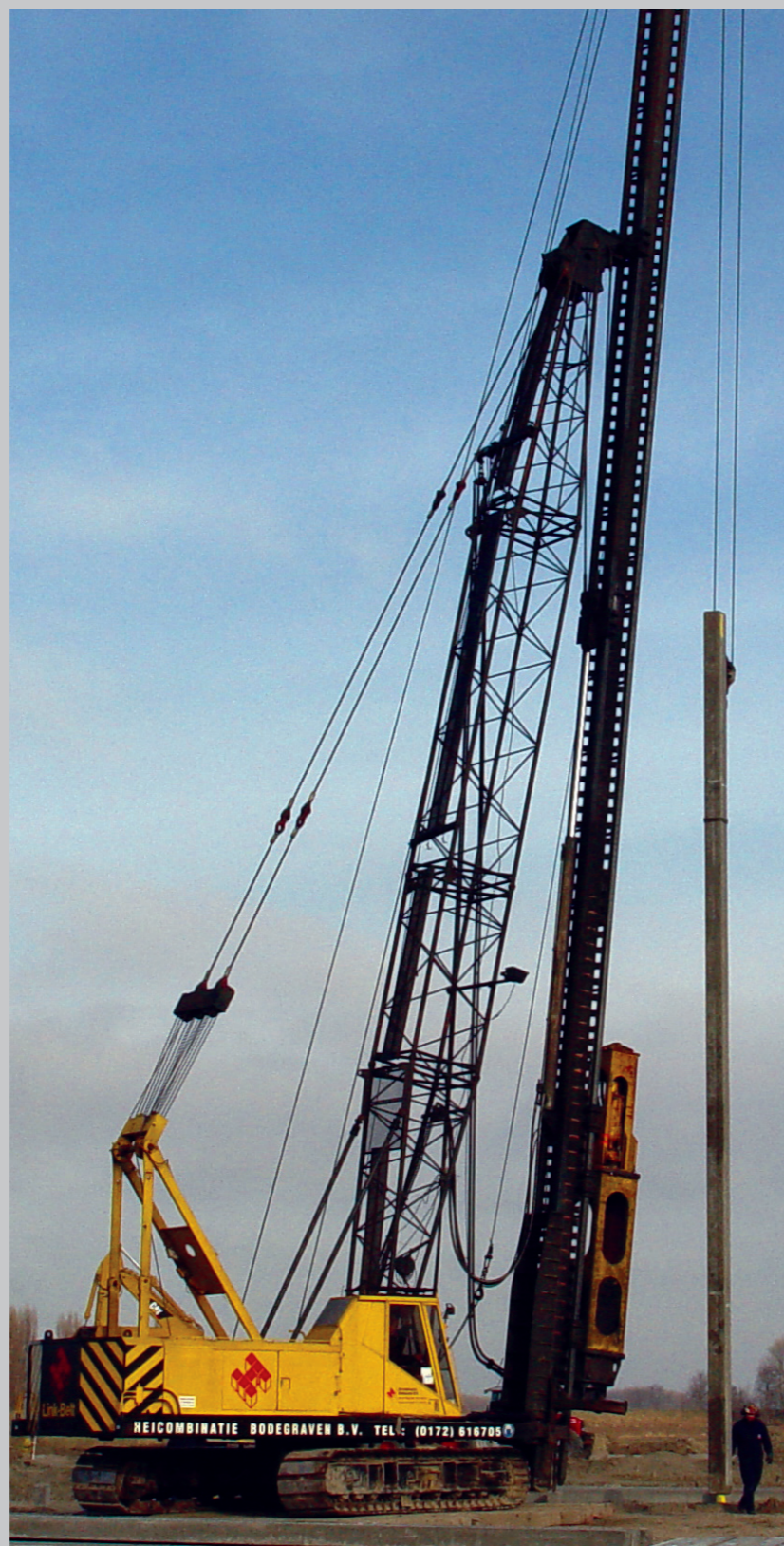
de feestelijke heipaal verticaal
